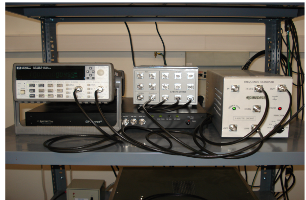
Fig 4. Foto del equipamiento que compone el sistema.
